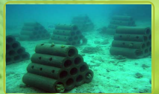
แท่งคอนกรีตรูปสามเหลี่ยมเพื่อเพิ่มพื้นที่การลงเกาะให้กับปะการัง
